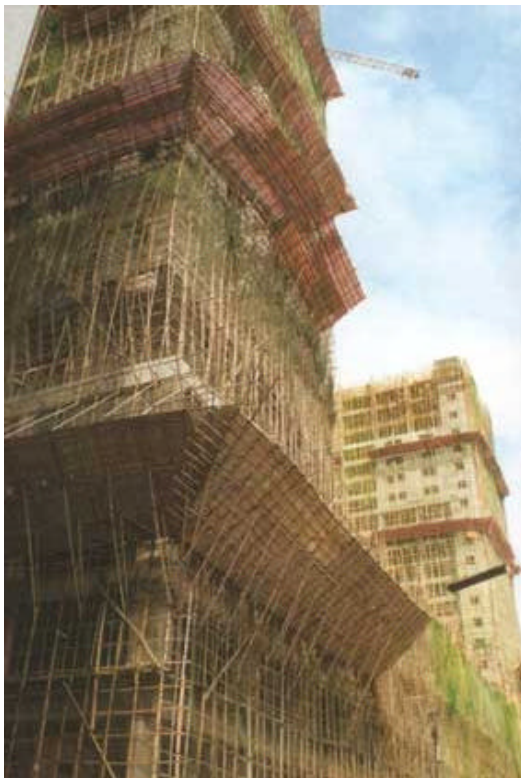
Baugerüst aus Bambusrohren
