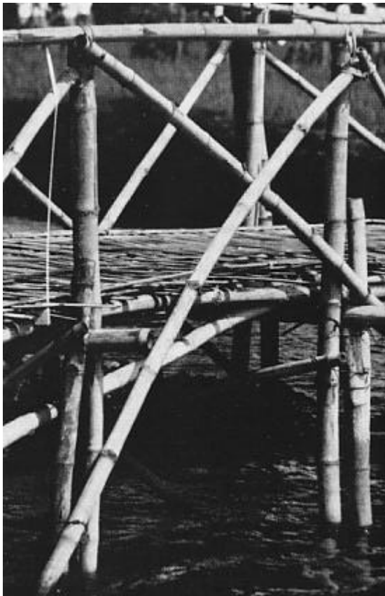
Brücke mit Zwischenpfosten
